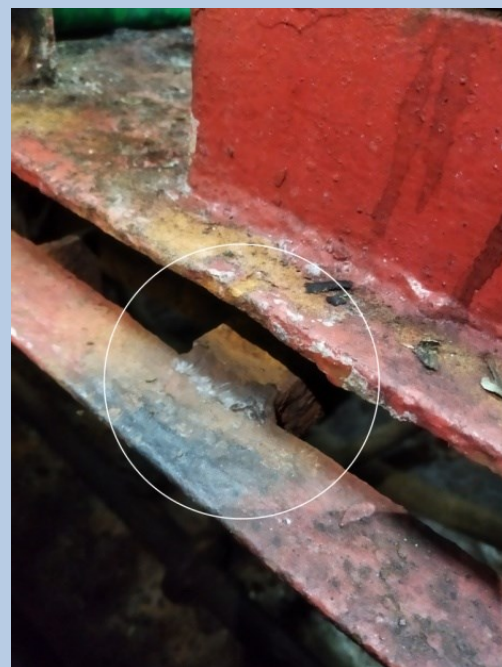
Το σημείο της ηλεκτροσυγκόλλησης
